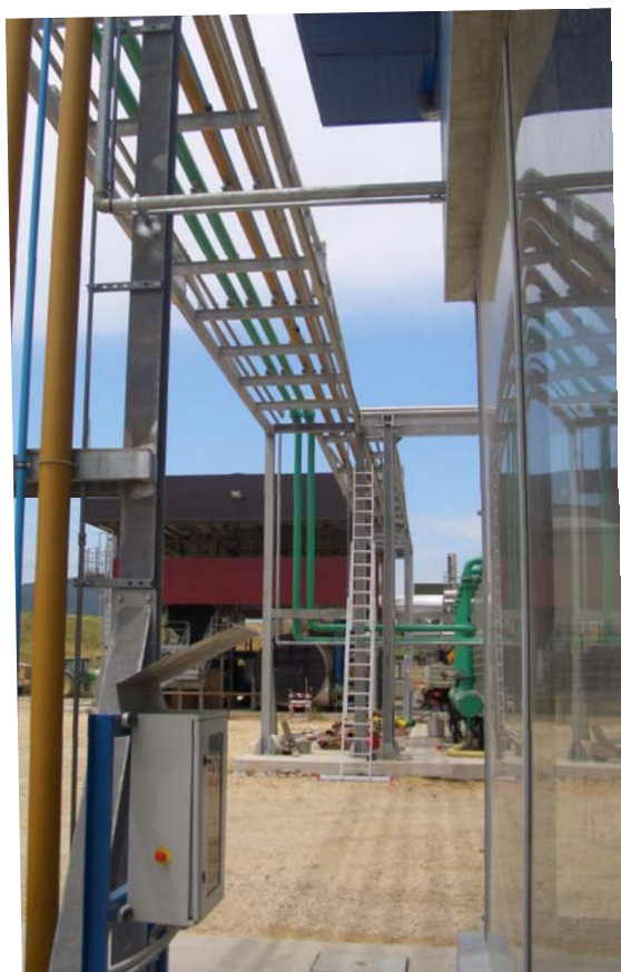
Sistema alimentazione acqua calda e fredda
