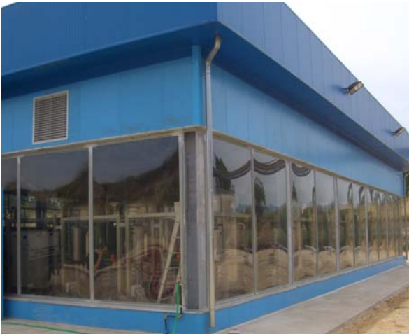
Locale distillazione percolato
